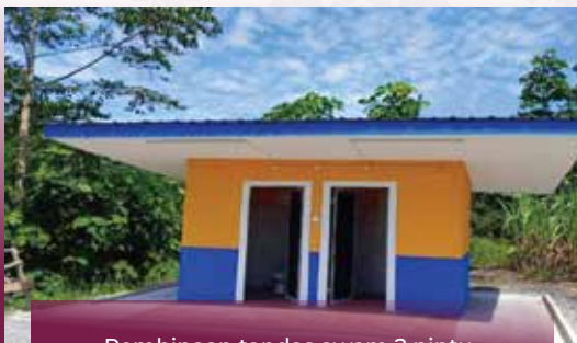
Pembinaan tandas awam 2 pintu
